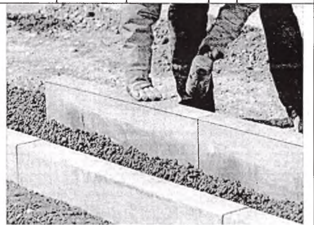
Установка или замена бордюрного камня
