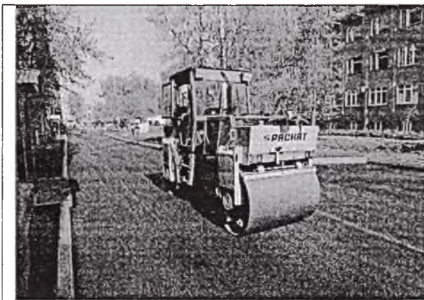
Асфальтирование дворовых проездов
