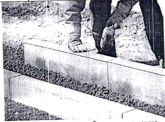
Установка или замена бордюрного камня
